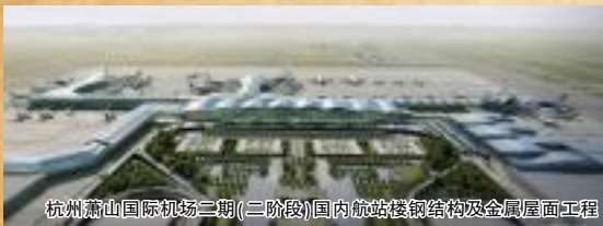
杭州萧山国际机场二期(二阶段)国内航站楼钢结构及金属屋面工程
